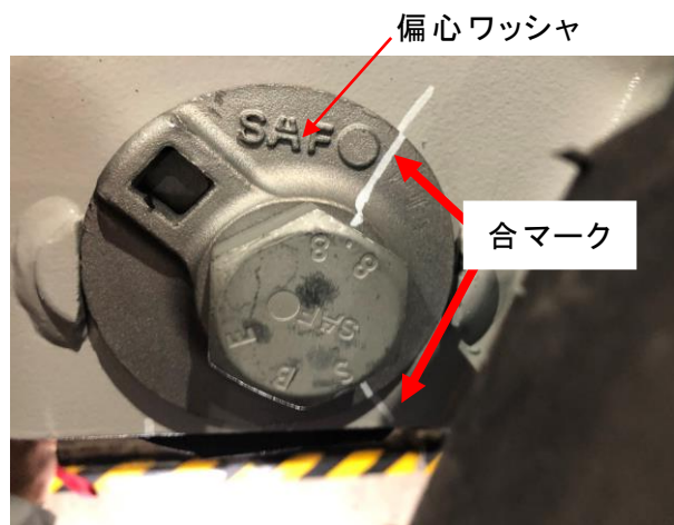
第3図. ピボット・ボルト部マーキング
